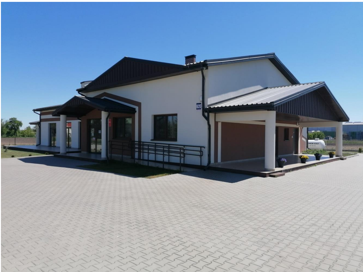
Budynek wietlicy wiejskiej w dąbrowie
