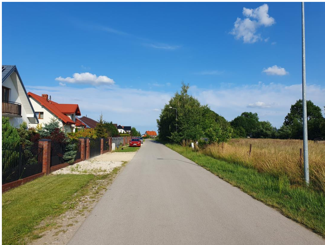
Fot. 4 Widok terenów 1MN-U (po lewej), 2MN-U (po prawej) i 1KDD (w środku) od zachodu.
