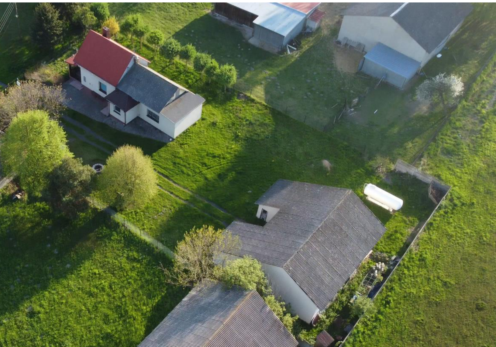
Fot. 1. Wykorzystanie wyrobów azbestowych jako pokrycia dachowe.
